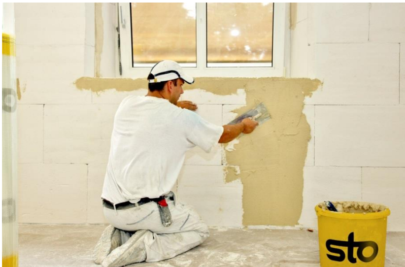
Bild: Verarbeitung der Sto Innendämmung
